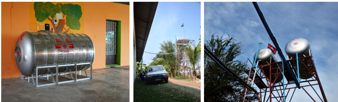
Installation des neuen Wassertanks
